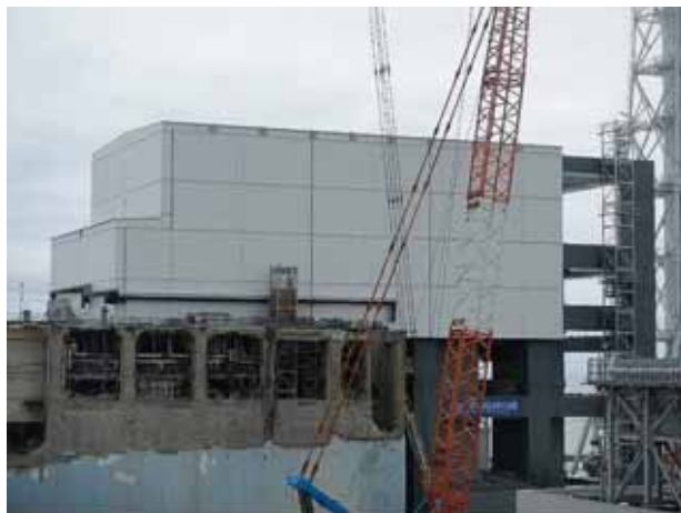
【4号機燃料取り出し用カバー】
