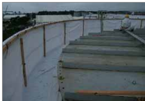
タンク歩廊部
