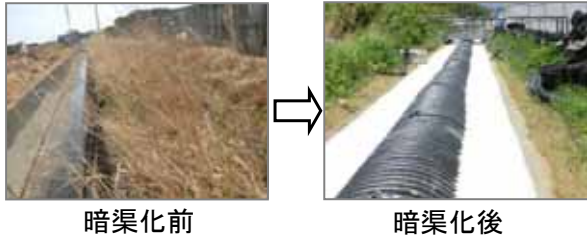
C排水路の暗渠化状況
