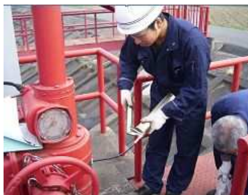
（ 取水ゲートの保守作業 ）
