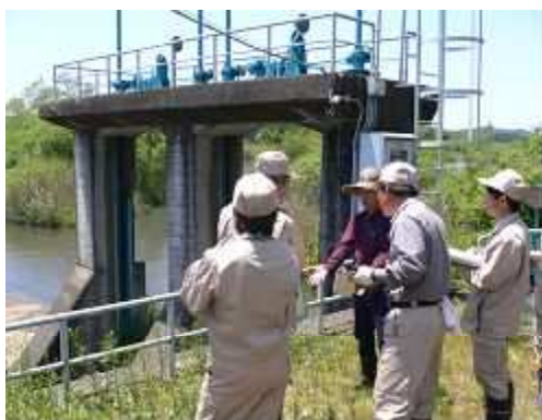
（ 取水堰（頭首工）の点検 ）
