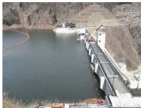
（滝川ダム 湛水試験中）
