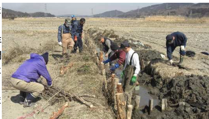
そださく （粗朶柵による「フカ」改修）
