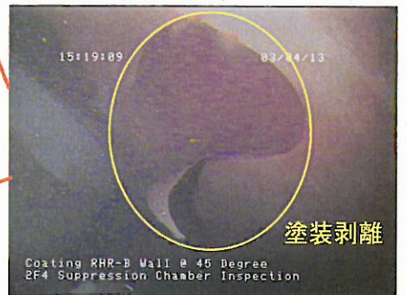
残留熱除去系（B）ストレーナ近傍壁面
