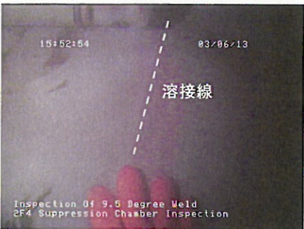
圧力抑制室底面
