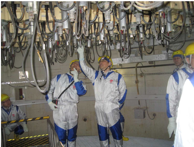
4号機原子炉圧力容器底部 (原子炉格納容器内)
