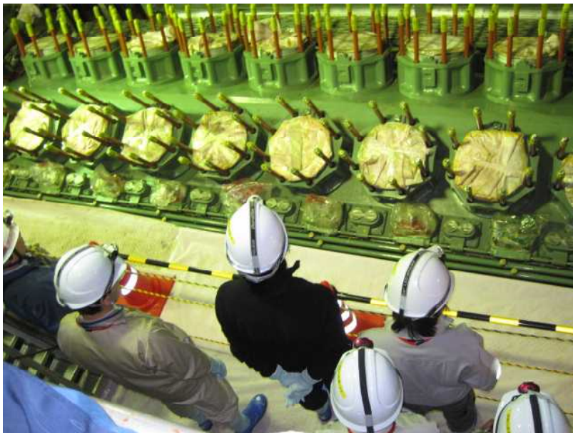
1号機非常用ディーゼル 発電機 (A系) [修理中] (原子炉建屋付属棟)
