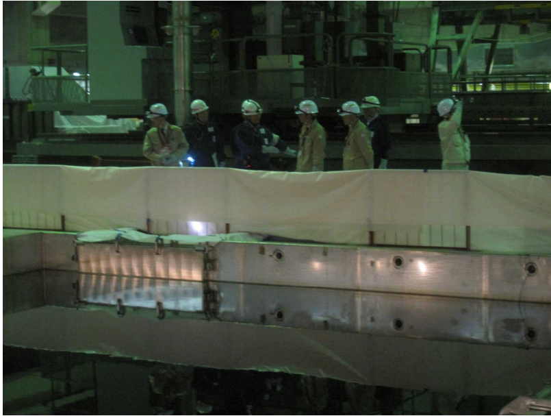
1号機使用済燃料プール (原子炉建屋 6階)
