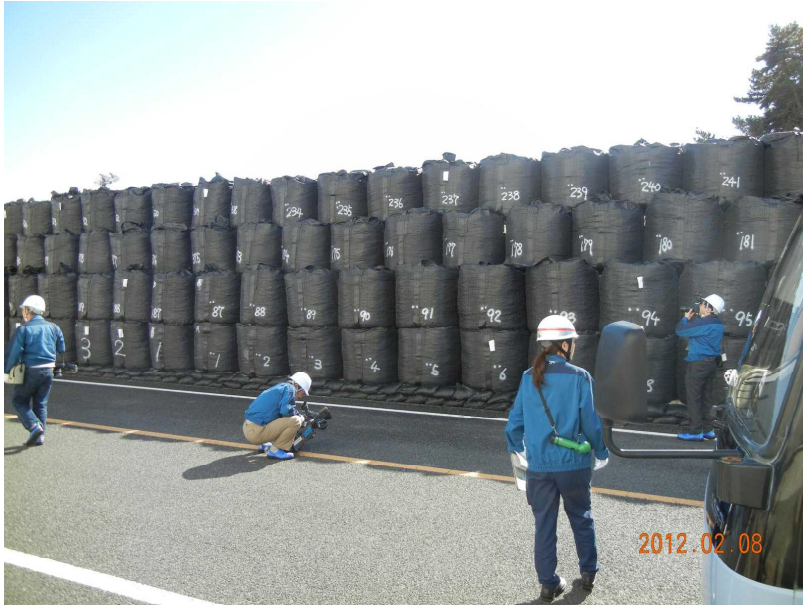
仮設防潮堤 (発電所南側海岸)
