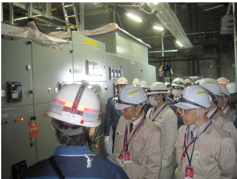
電源盤〔復旧〕 (4号機海水熱交換器建屋)
