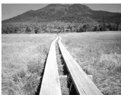
尾瀬地区（木道整備）
