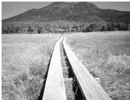
尾瀬地区（木道整備）
