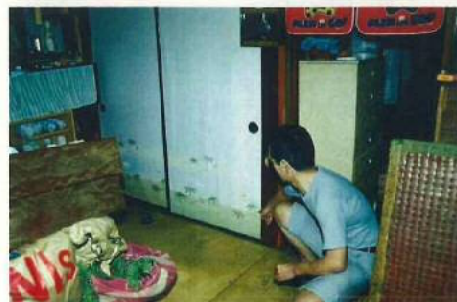
平成10年7月29日床上浸水(大神宮橋右岸)
