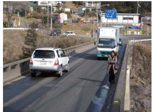
▲霊山松川線 逢隈橋（福島市）
