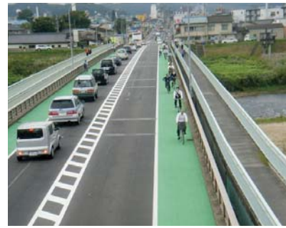
●（-）水原福島線外 福島市外工区（福島市 信夫橋付近）
