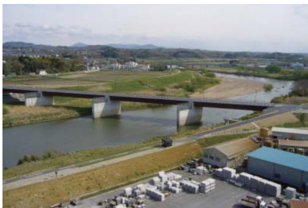
国道288号（富久山バイパス）の整備状況
