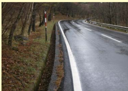
路肩がせまく走りづらい道路
