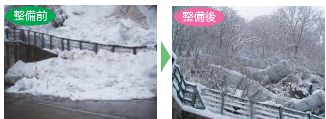
雪崩を防ぐ道路(雪崩防止柵) 国道121号(熱塩)喜多方市
