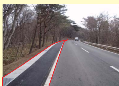
側溝の位置を工夫して路肩を広げた状況
