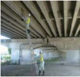
橋梁の定期点検実施状況
