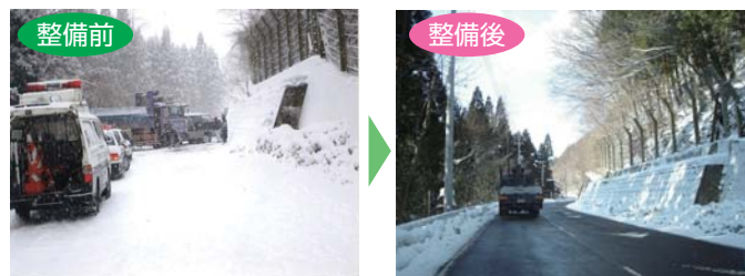
雪を融かすことができる道路（無散水消雪施設） 国道118号（鳳坂峠）天栄村
