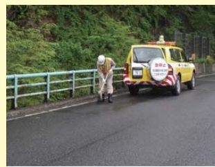
パトロールで発見した損傷箇所を応急処置などを塗り替えて景観の向上を図る
