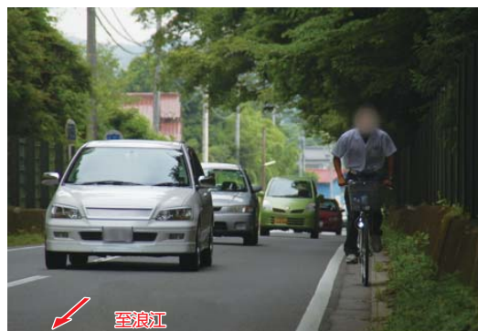
浪江鹿島線（鶴谷工区）
