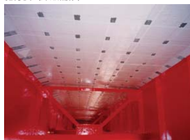
施行後（床版補修）
