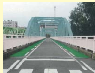
補修時等に地域の意見を聞きながら橋梁の防護柵などを塗り替えて景観の向上を図る
