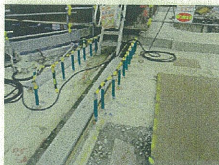
床面アンカーボルトの打設後養生状況
