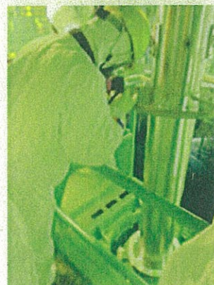
燃料取扱機上にて燃料のつかみ状況を双眼鏡で確認している状況。
