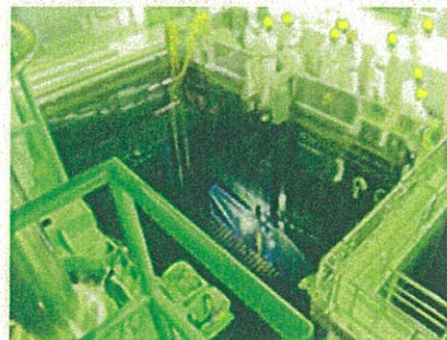
共用プール内に水中テレビカメラ・照明灯を投入し、燃料集合体の確認作業状況
