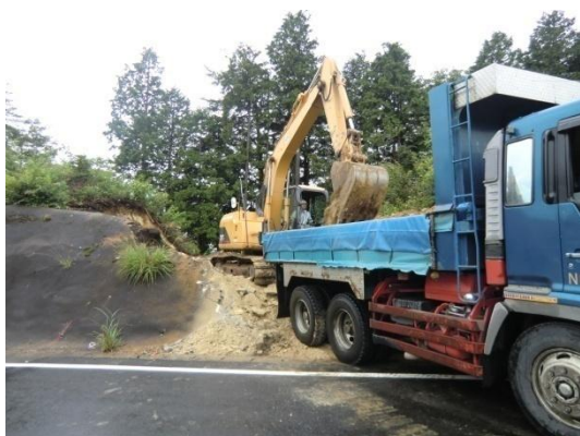
写真：土砂掘削の様子
