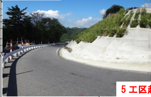
施工状況④
