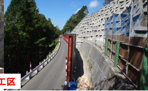
施工状況①
