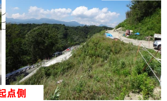
施工状況⑤
