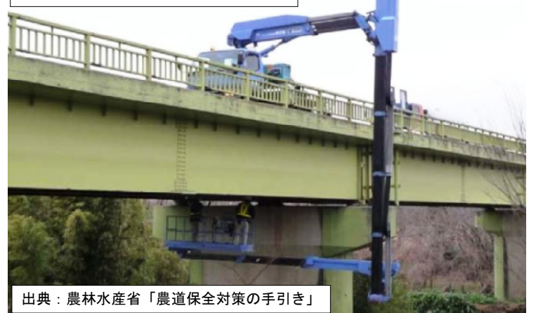
点検車両による橋の点検
