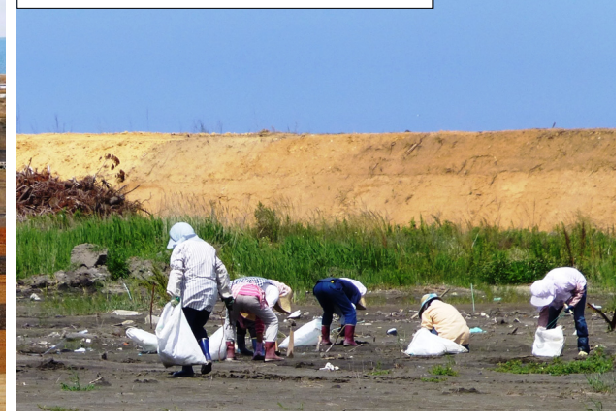
手作業でのガレキ撤去作業
