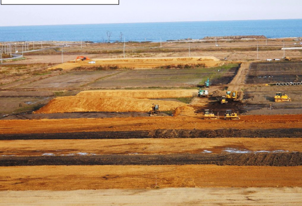
基盤整地の状況
