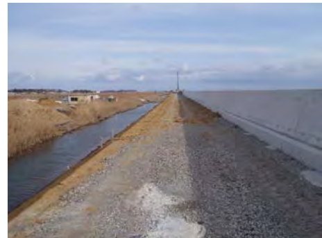
松川浦堤防復旧状況
