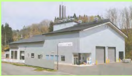
木質バイオマス発電施設
