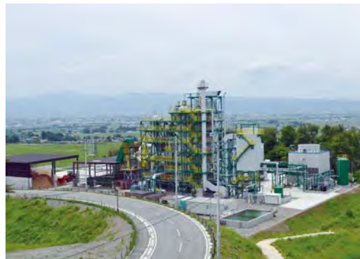
木質バイオマス発電施設((株)グリーン発電会津)
