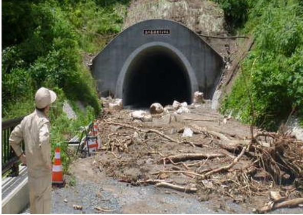
玉の湯温泉トンネル (国道288号・大熊町)
