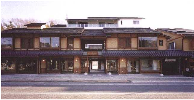
写真 まちなみにあった店舗と共同住宅（三春町）
