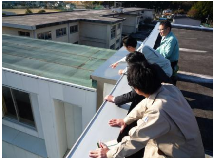
(災害査定現地調査の様子)
