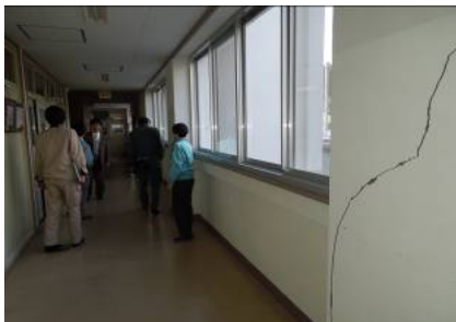
(災害査定現地調査の様子)
