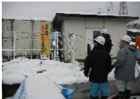
(災害査定現地調査の様子)
