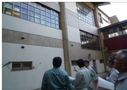
(災害査定現地調査の様子)
