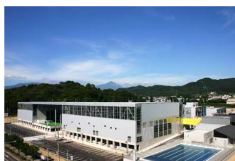
南西側から見た新校舎
