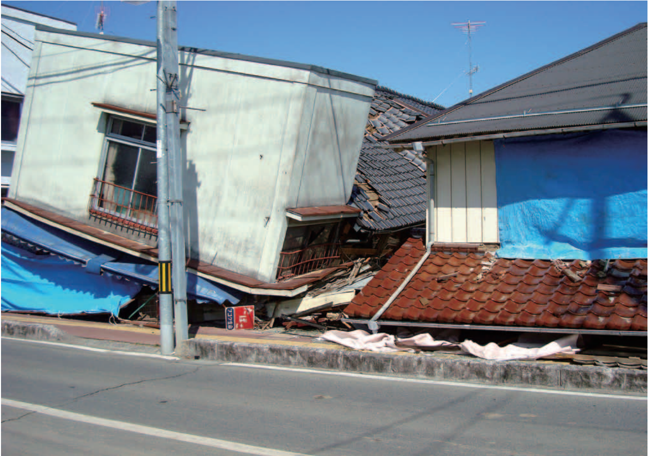
南相馬市小高中付近倒壊家屋 平成 23 年 3 月 12 日撮影
