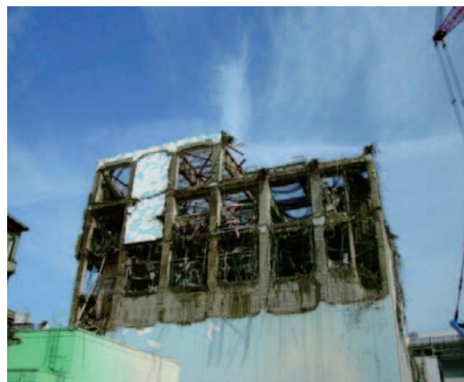
福島第一原子力発電所 4号機建屋上部 (平成24年3月5日撮影)
