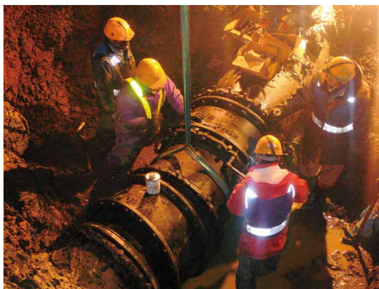
浄水場送水管漏水の修理
