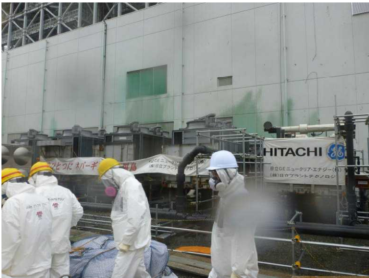
○4号機使用済燃料プール 代替冷却設備
