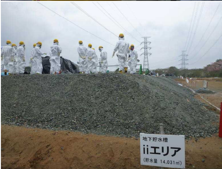
○地下貯水槽 No.2
