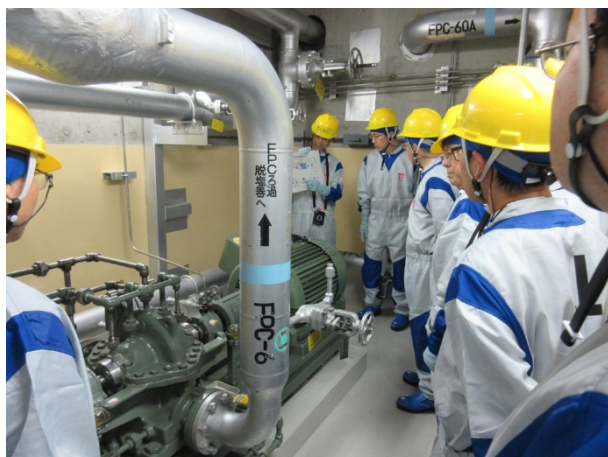
燃料プール冷却浄化系ポンプを確認している状況
