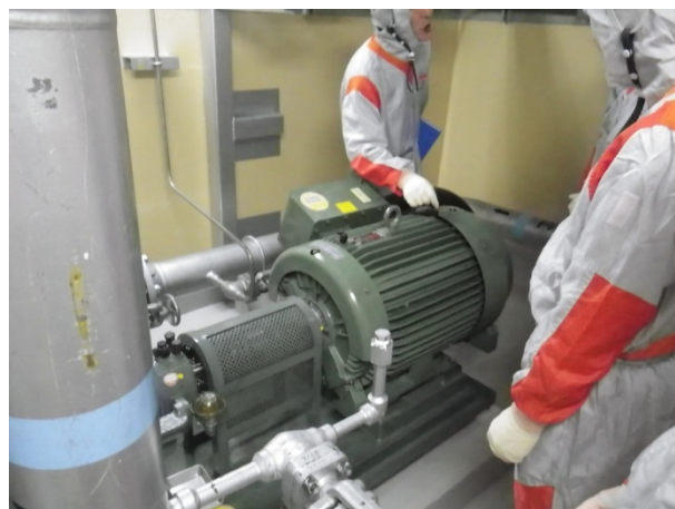
燃料プール冷却浄化系ポンプを確認している状況
