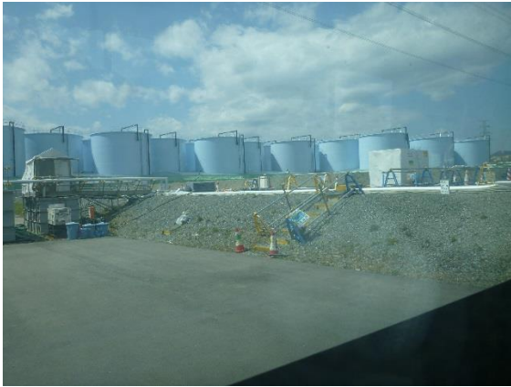
地下貯水槽外観（砕石が盛られている箇所の下に地下貯水槽が設置されている）
