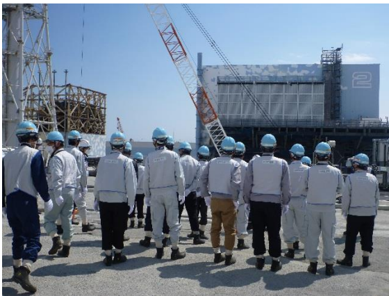
1/2号機開閉所付近から建屋外観を確認している様子
