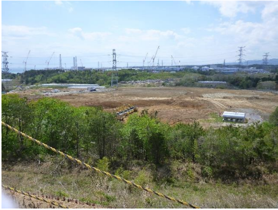
廃棄物関連設備の建設予定地（造成作業が進んでいた。）
