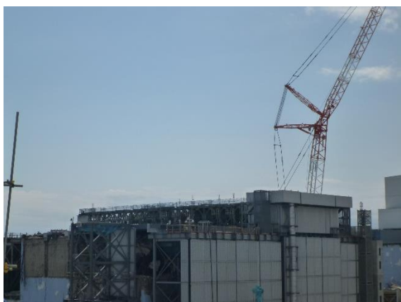
3号機原子炉建屋外観（使用済燃料取り出し用カバー設置工事が進捗していた。）
