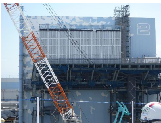
2号機原子炉建屋外観（開口設置作業用の前室が設置されていた。）
