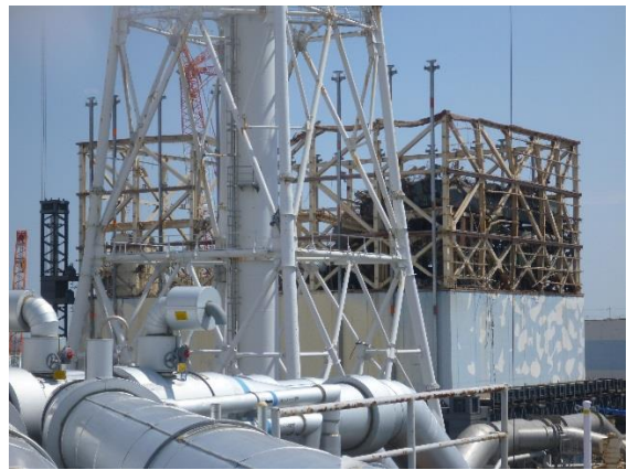
1号機原子炉建屋外観（最上階のガレキ撤去に向けて防風シートの設置が行われる予定）
