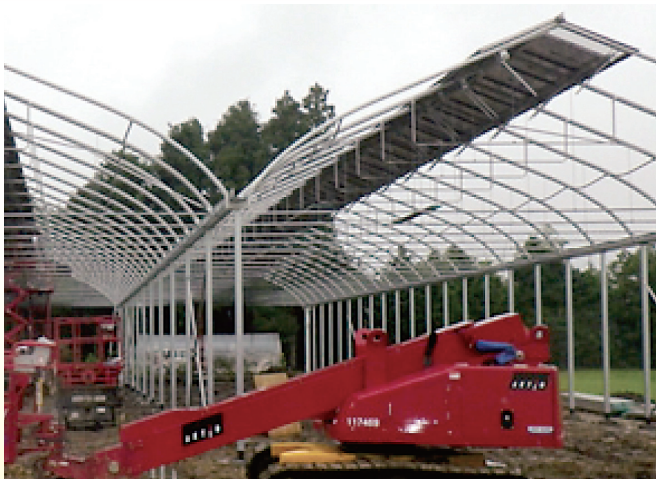
写真 1 ハウスの天窓に太陽光パネルを設置した様子
