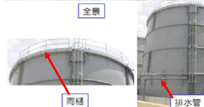
<タンク雨樋設置状況>
