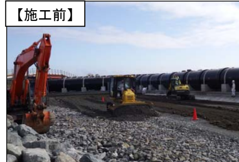
<4m盤アスファルト舗装施工状況(1～4号機放水口周辺)> (1月実績箇所)
