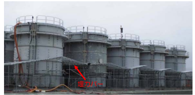
<タンク堰カバー設置状況>
