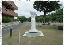
④浄化センター 管理棟付近
