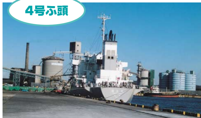
4号ふ頭 濃硫酸や苛性ソーダ等の化学工業品が扱われています。ふ頭先端部では、危険物のタンク等が集約されています。
