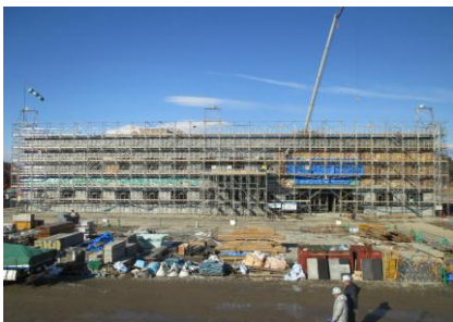
三春町施設本館建設工事の様子 (平成26年12月24日現在)
