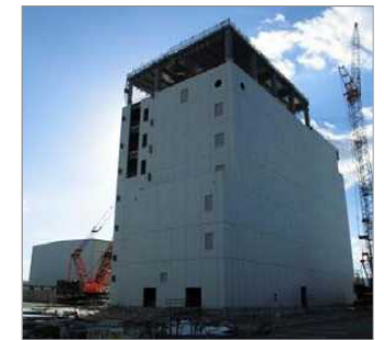
建設中の大型休憩所
