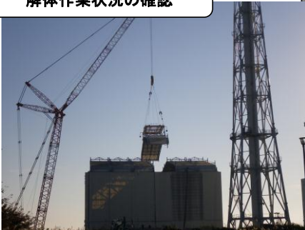
1号機原子炉建屋カバー解体作業状況の確認
