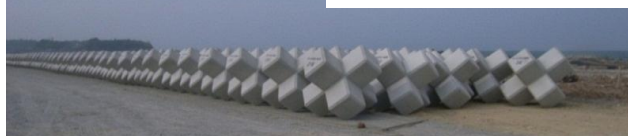
消波ブロックの製作状況 (塚原地区海岸)
