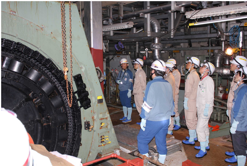
1号機非常用ディーゼル 発電機 (1号機原子炉建屋付属 棟地下2階)
