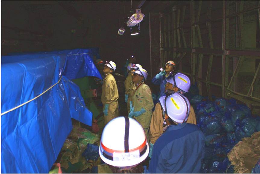
1号機非常用ディーゼル 発電機給気ルーバー室 (1号機原子炉建屋付属 棟1階、建物内)
