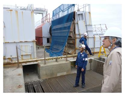
・トラベリングスクリーンに よる冷却水取水時の漂流ゴミ の除去方法を確認
