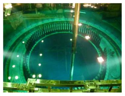
・4号機燃料移動作業 燃料交換機から伸びるアーム(ホイスト)による原子炉 内の燃料等の移動を確認。
