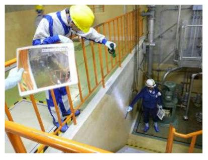
・地下 2 階フロアから更に半 地下部分での津波による浸水 位置。(約110cm)
