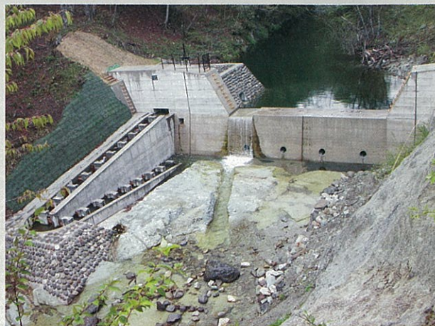
No3治山ダムと魚道(左側)
