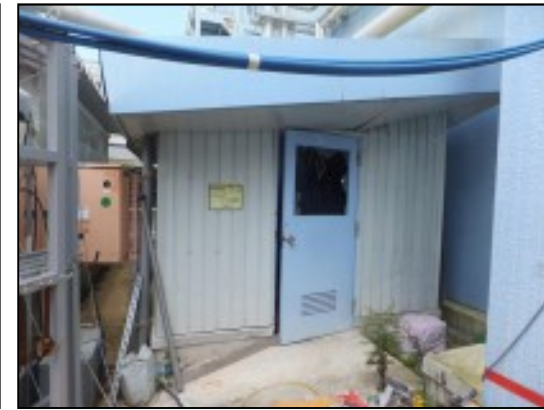
④HCU窒素ガスポンベ室
