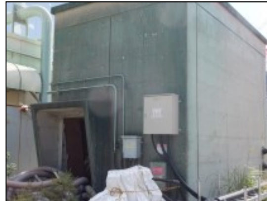
⑦セメントブロアー室
