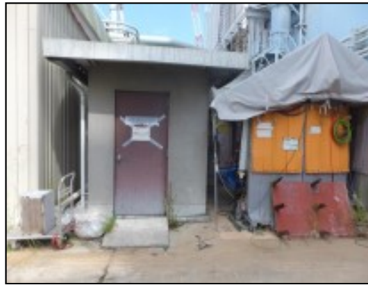
③補助ボイラー窒素ガスポンベ室
