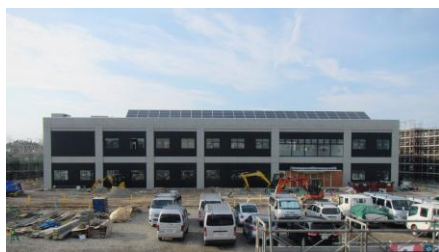
三春町施設本館建設工事の様子 (平成27年7月2日現在)
