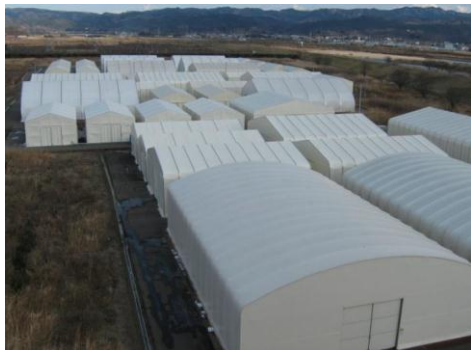
汚泥臭気を抑えるためのテント群
