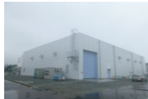
③サブドレン浄化設備建屋
