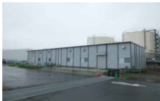
①移送設備建屋
