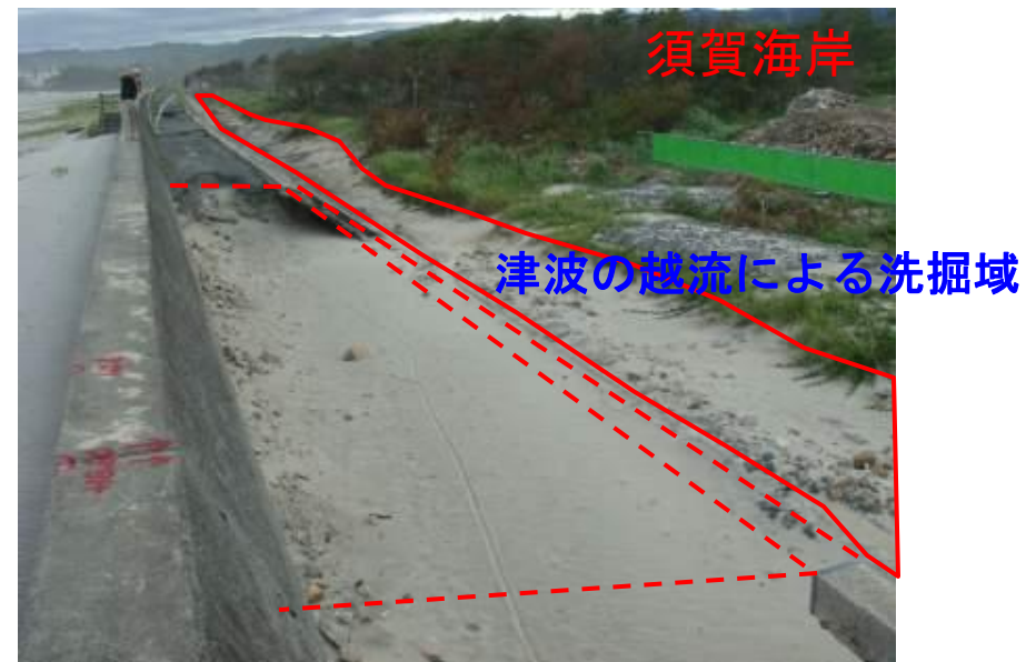
裏法尻洗掘による天端・裏法倒壊例
