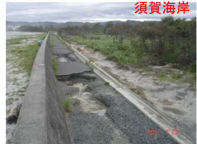
アスファルト舗装の天端工の被災例
