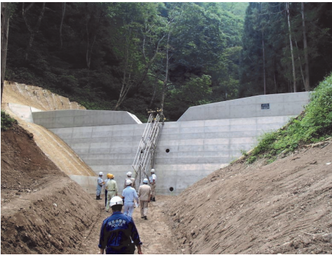
細窪地区(谷止工)安全パトロール状況
