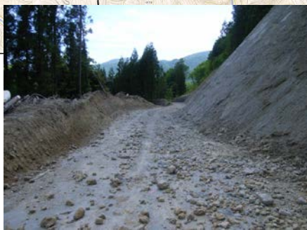
施 工 中 の 様 子
