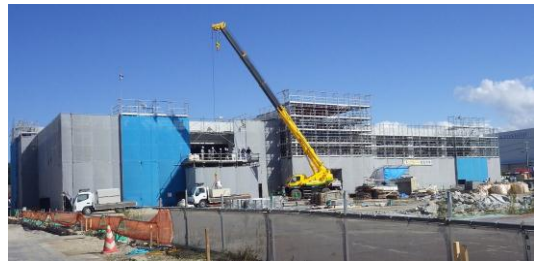
三春町施設交流棟(コミュタン福島) 工事の様子 (平成27年10月6日現在)
