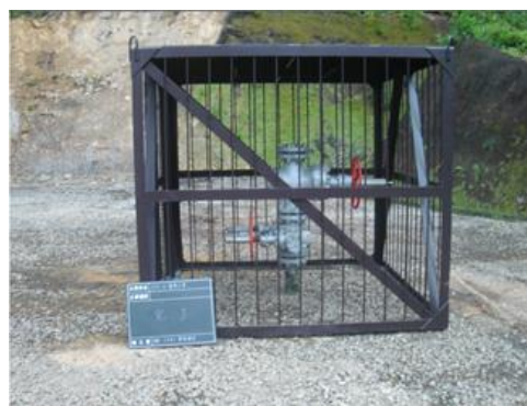
坑口装置（掘削工事終了後）
