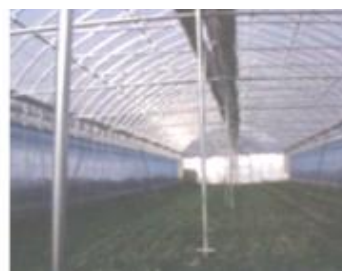
中柱（仮支柱）設置の写真
